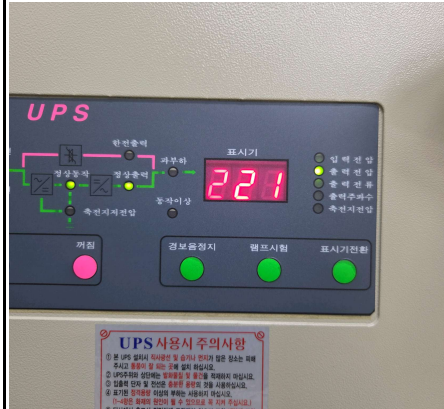
메인 서버 UPS 배터리 디스플레이 확인
